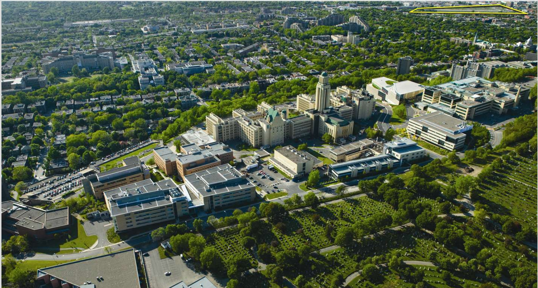
LE PAVILLON DES SCIENCES AU SITE OUTREMONT
