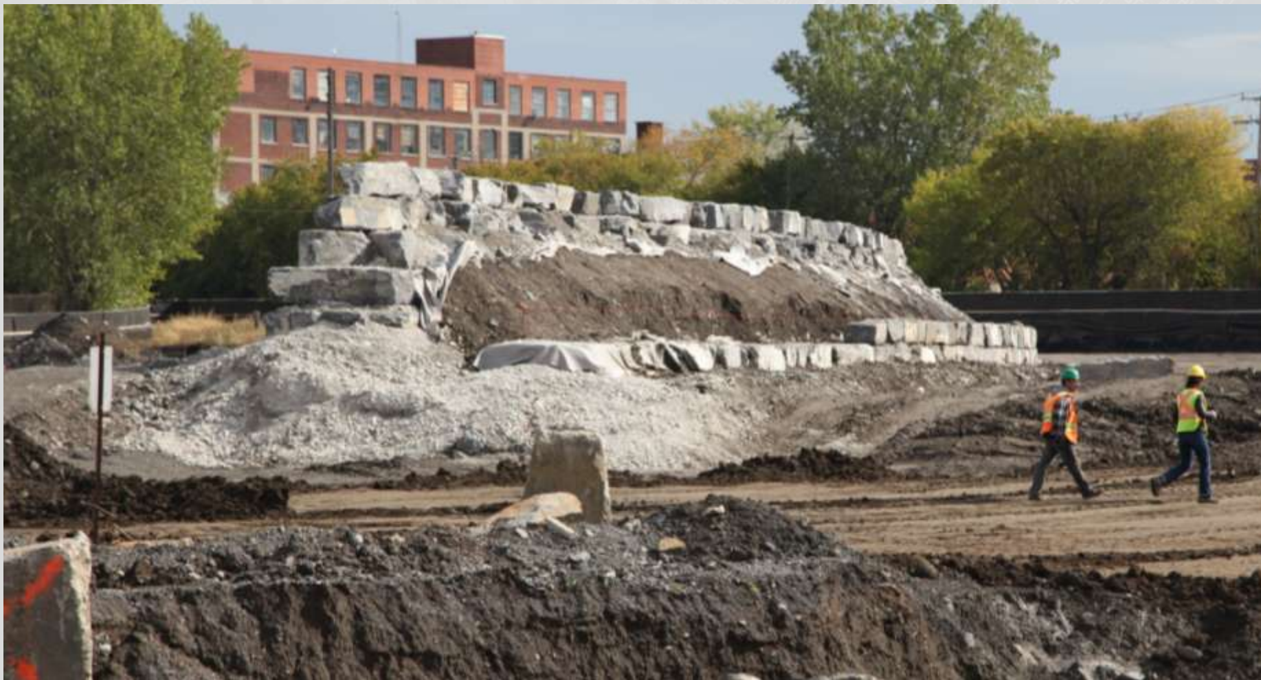
LE PAVILLON DES SCIENCES AU SITE OUTREMONT
